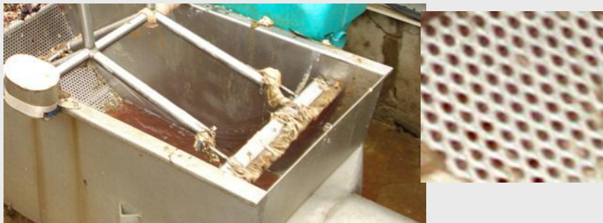
Εικόνα 20 Φίλτρο συγκράτησης ΖΥΠ > 6mm κατά τη διέλευση των υγρών αποβλήτων των πτηνοσφαγείων
